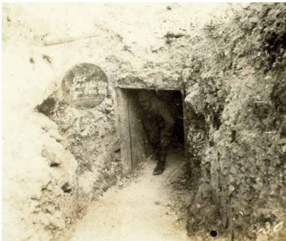
Overdækket gang ud til sape. Til venstre for indgangen hænger en metalplade med indskriften: "Må kun benyttes ved gasalarm". Ved gasangreb slog man på metalpladen som en gong-gong. (Jørgen Bendorff)
