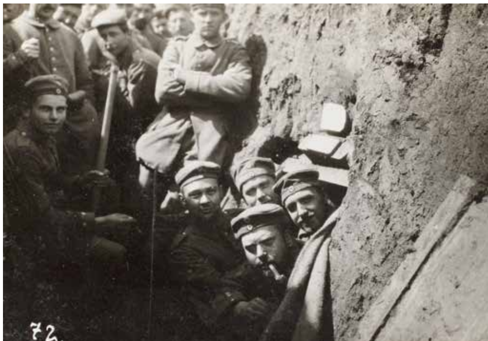
Primitiv løbe- eller dækningsgrav ved Moulin-sous-Touvent. Siderne er ikke afstivet og i det våde franske vintervejr skred de derfor nemt sammen og dannede et sejt mudder, som gjorde færdsel i gravene til en meget besværlig for slet ikke at tale om beskidt beskæftigelse. (Sønderborg Slot)
