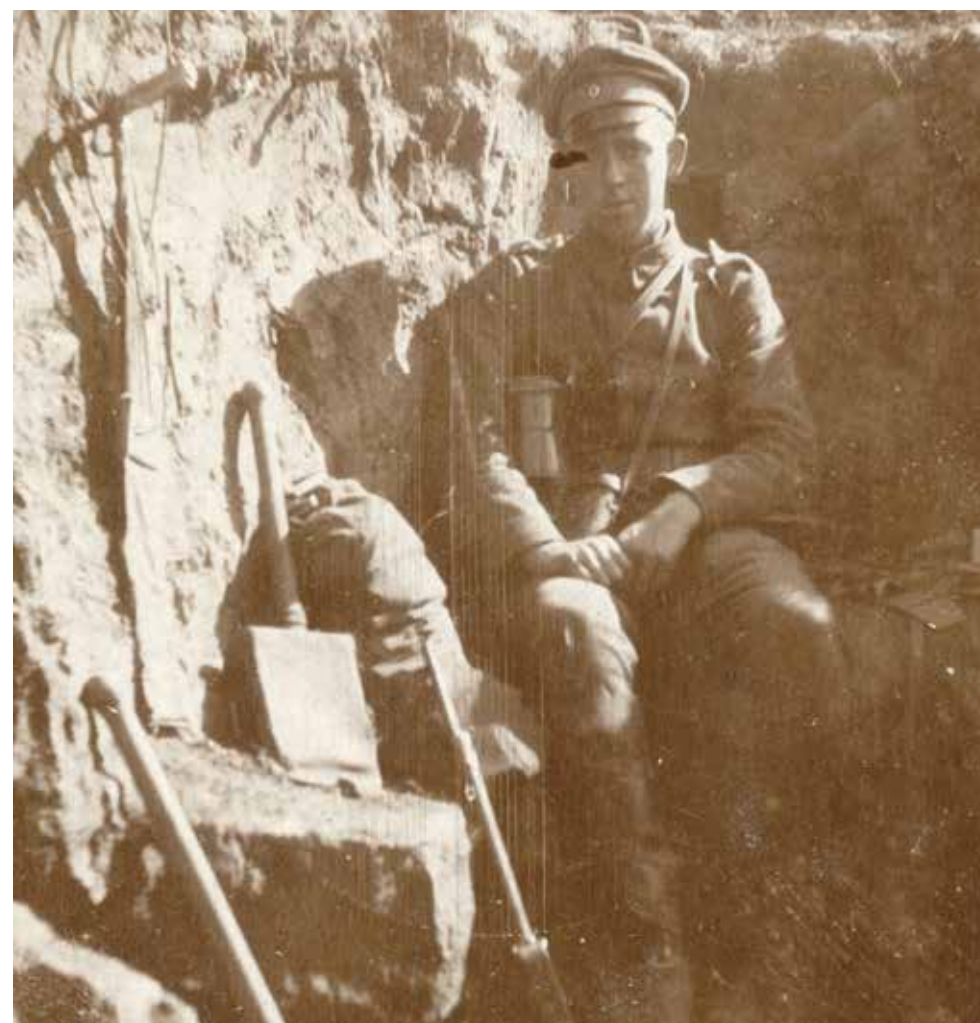
Jens Holdt i hvad der kunne være en frisk gravet eller udbedret skyttegrav. Der er ingen afstivning, og ud over feltspaden ved siden af Holdt ses skaftet på endnu et graveredskab. Han har geværet ved hånden og til venstre for ham hænger en bandoler med ekstra ammunition. Holdt var ikke med anden gang ved Somme, da han var blandt fire heldige officerer, der fik orlov. (Jørgen Bendorff)
