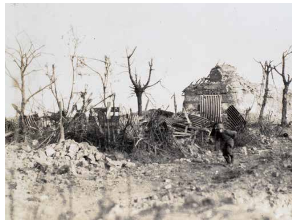
"Betonforstærket hus ved Draibank" lyder teksten til billedet i 86'ernes Flandern-album. Ofte forstærkede man allerede eksisterende bygninger, og man aner også både murværk og spær fra taget. Fotoet optræder også i regimentshistorien: "Betonklods efter beskydning". (Sønderborg Slot)
