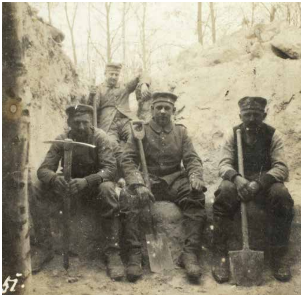
Udgravning til dækningsrum ved Moulin-sous-Touvent. Gravarbejde udgjorde en stor del af soldaternes daglige tjeneste: der skulle anlægges nye dækningsrum og skyttegravene vedligeholdes og udbygges. (Jørgen Bendorff)
