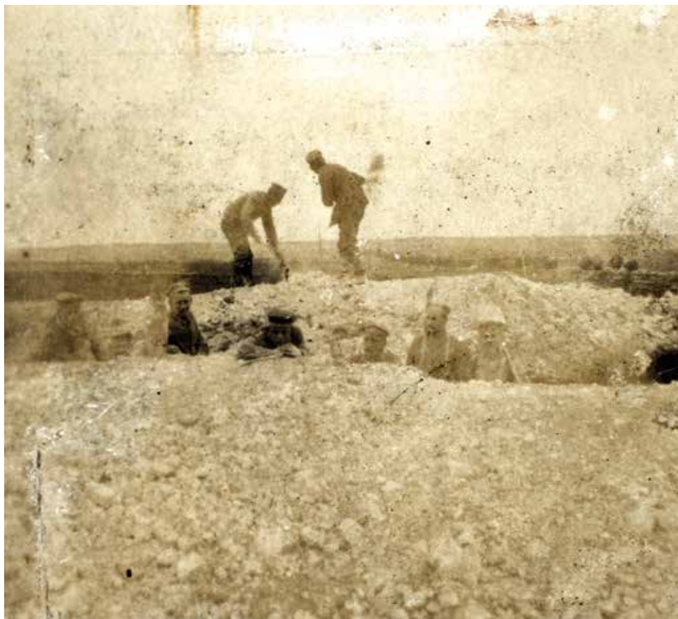
Gravning af dækningsrum i tredje linje "K3". Mens mandskabet i graven holder pause og poserer for kameraet, har deres to kammerater på kanten af skyttegravnen travlt med at sprede den opgravede kridt. (Jørgen Bendorff)
