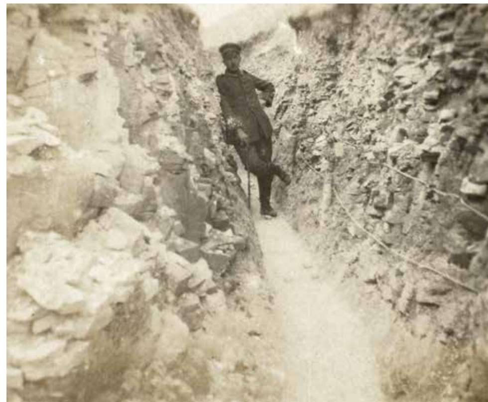
Flensborgvej, en af flere løbegrave som 86'erne anlagde, og som forbandt de forreste skyttegrave med baglandet. Langs skyttegravens højre side ses to telefonledninger. (Jørgen Bendorff)
