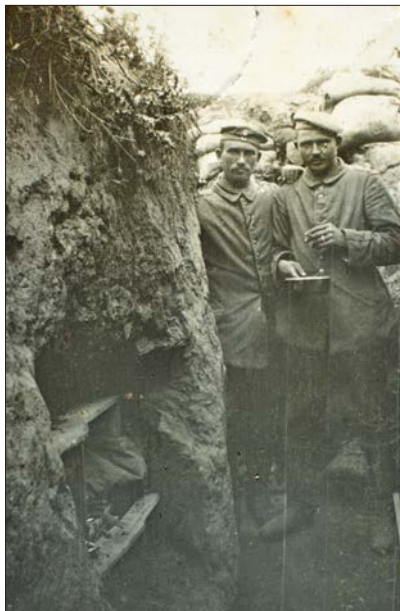
To tyske soldater ved indgangen til sape nr. 25 ved Moulin. Saperne havde gerne indskudt en mur af sandsække på tværs af graven, så der hurtigt kunne etableres et forsvar, hvis sapehovedet faldt i fjendens hænder (foto: Cay-Erik Geipel).
