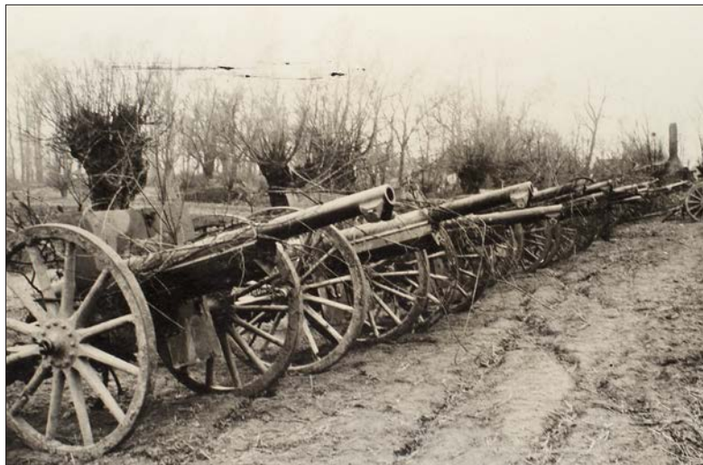
En hel række af den berømte franske 75 mm kanon. Det var den første feltkanon med rekylbremse, hvilket betød, at kun løbet og ikke hele kanonen løb tilbage, når den afgav skud. Det betød, at den ikke skulle ruller frem i stilling efter hvert skud, hvilket gav en hurtigere og mere præcis skydning. 75'eren udgjorde i begyndelsen af krigen ryggraden i det franske artilleri, således også ved angrebet 6. juni 1915. Men den var beregnet til bevægelseskrig og ikke synderligt egnet til ødelæggelse af skyttegrave, da dens skudbane var for flad og dens 5,4 kg tunge sprænggranat ikke kraftig nok (foto: Dan Obling).
