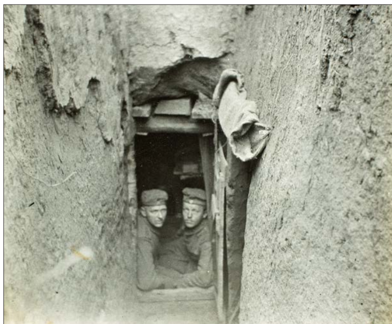
To tyske soldater titter ud af indgangshullet til en understand (et dækningsrum) i skyttegravene ved Moulin. Loftet er understøttet med stolper og brædder. Det var tilstrækkeligt mod feltkanoner, men ikke solidt nok til at kunne modstå beskyddning af svært artilleri (foto: Cay-Erik Geipel).
