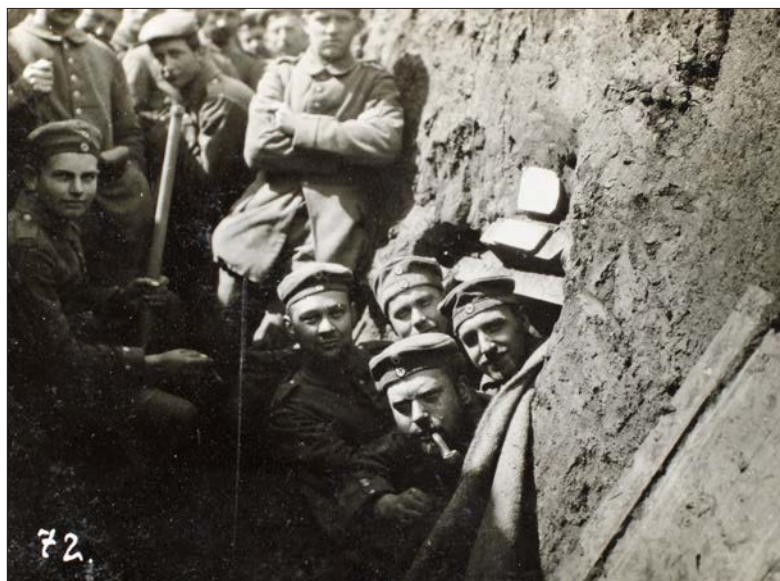
Soldater fra Füsilier-Regiment Nr. 86 ved Moulin 1915 i en primitiv forbindelsesgrav uden nogen former for afstivning. Der skulle ikke meget til hverken af nedbør eller artilleribeskydning for at få siderne til at styrte sammen, og nedgangen til dækningsrummet, som de fire soldater kikker ud af til højre, har heller ikke kunnet holde til andet end den aller letteste beskydning (foto: Museum Sønderjylland).
