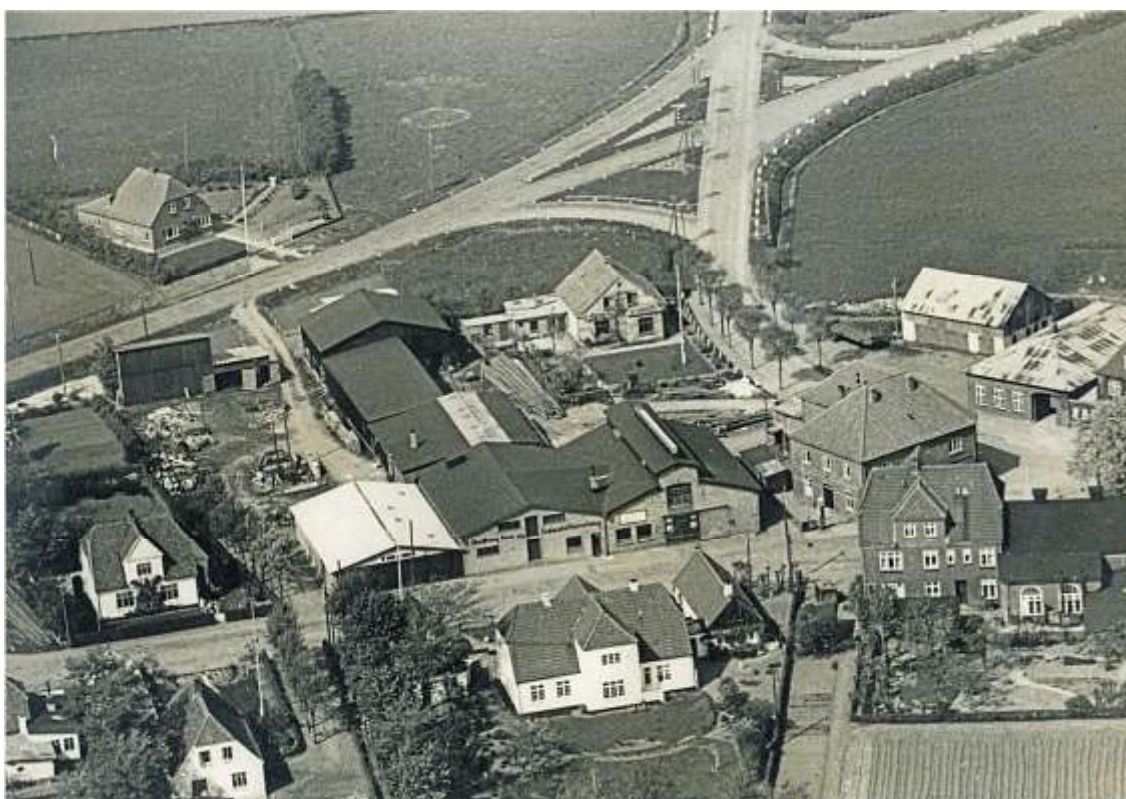
Luftfoto fra 1947 (Sylvest Jensen Luftfoto), hvor Foderstofforretningen fik sin første kornsilo, og Vesterkroen har stadig sin rejsestald, hvor der senere blev festsal. – Øverst til venstre den gamle ringriderplads, og på græsmarken øverst til højre den nye, indtil området blev bebygget.
