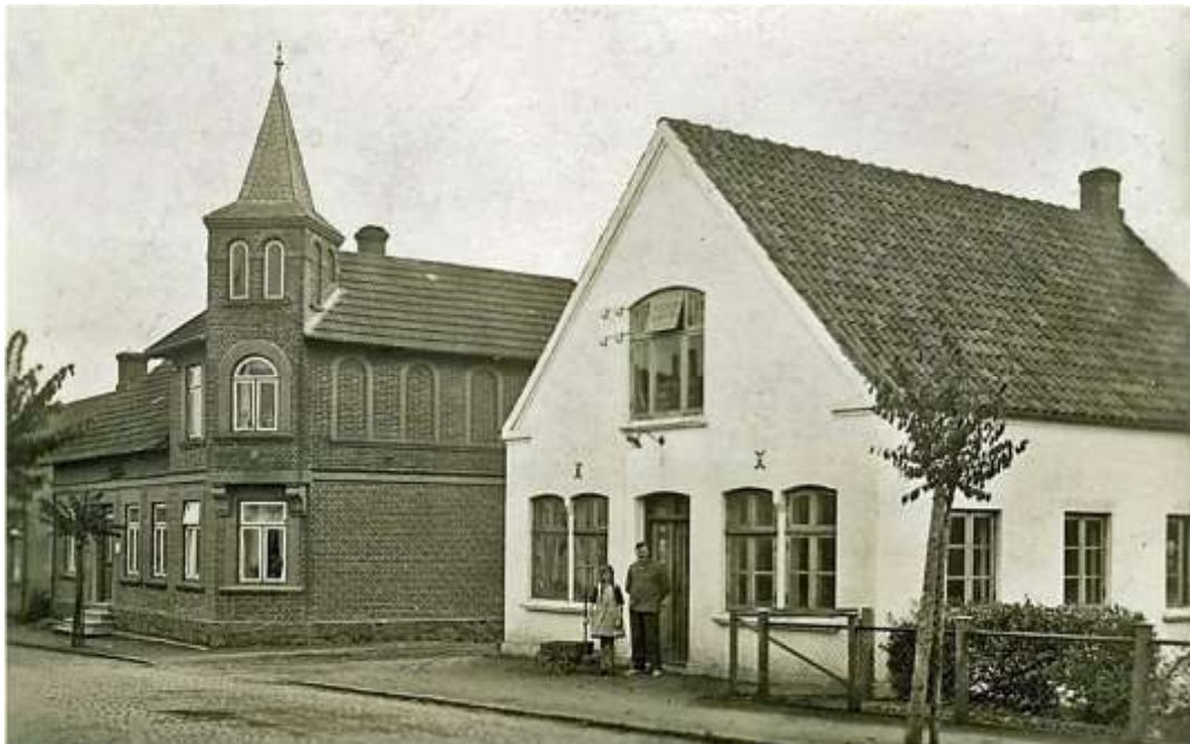
Jens Søeberg sammen med datteren Annelise foran det nye værksted, ca. 1927. Til venstre beboelseshuset.
