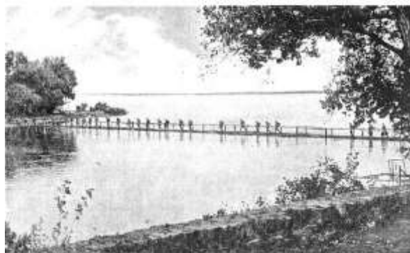
Brücken zwischen Hahndorf-See und Hahndorf-See, 1. Oktober 1918.
