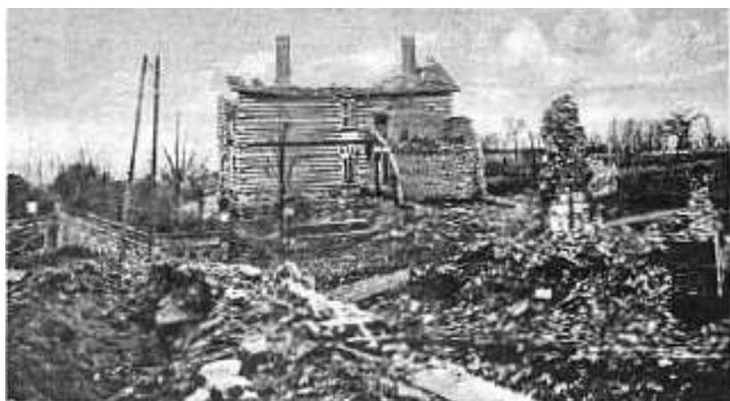
Das zerstörte Pfarrhaus von Serdon (Argonnen) September 1914.
