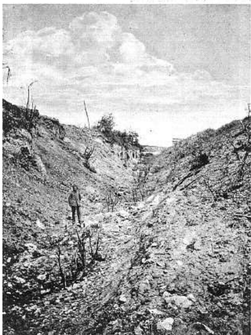
Grabenstück am Fort Malmaison, Juni 1917.
