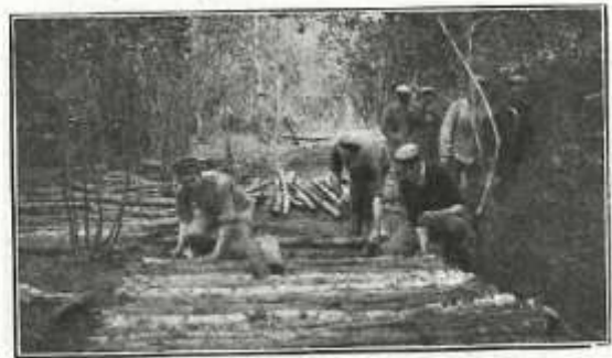
Feuerstellung der 1. Batterie im Walde von Ourscamp im Bau und vollendet
