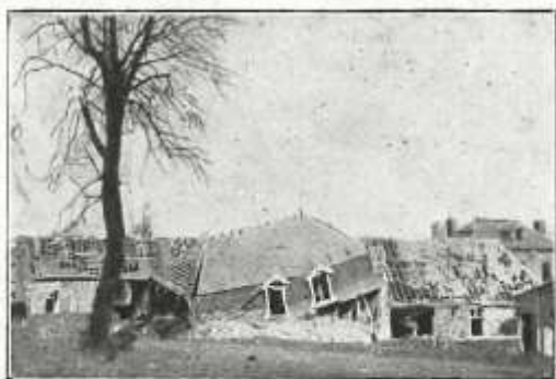
Sprengungen am Marktplatz
