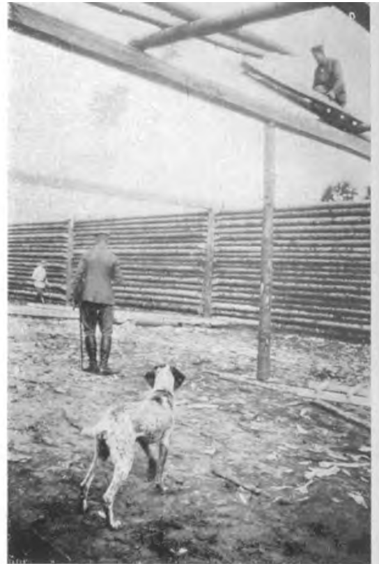
Bau der Reitbahn in Beresowka, 4. Husaren 16.
