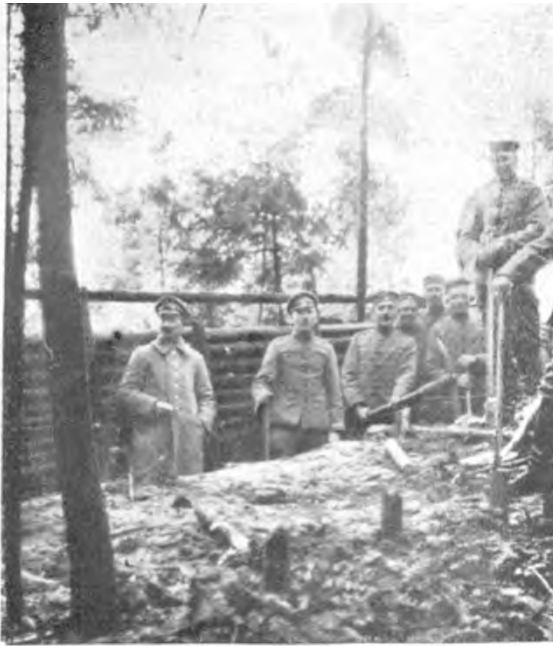
Bau der Brustwehr in Zucker, 4. Husaren 16. Strohmeier, Voß, Gofsch, Krug, ???.
