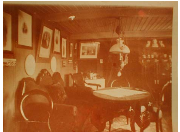
Ebbedamvej 3 "Æ dørrns", stuen. Bothilde og J.P. Lorenzen stue med de gamle møbler og billeder.
