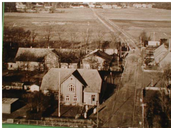
Hostrupvej 26. Martha og Calle Andresens købmandsforretning. Nu er der Spar-forretning ved Christel og Erling Carl.
