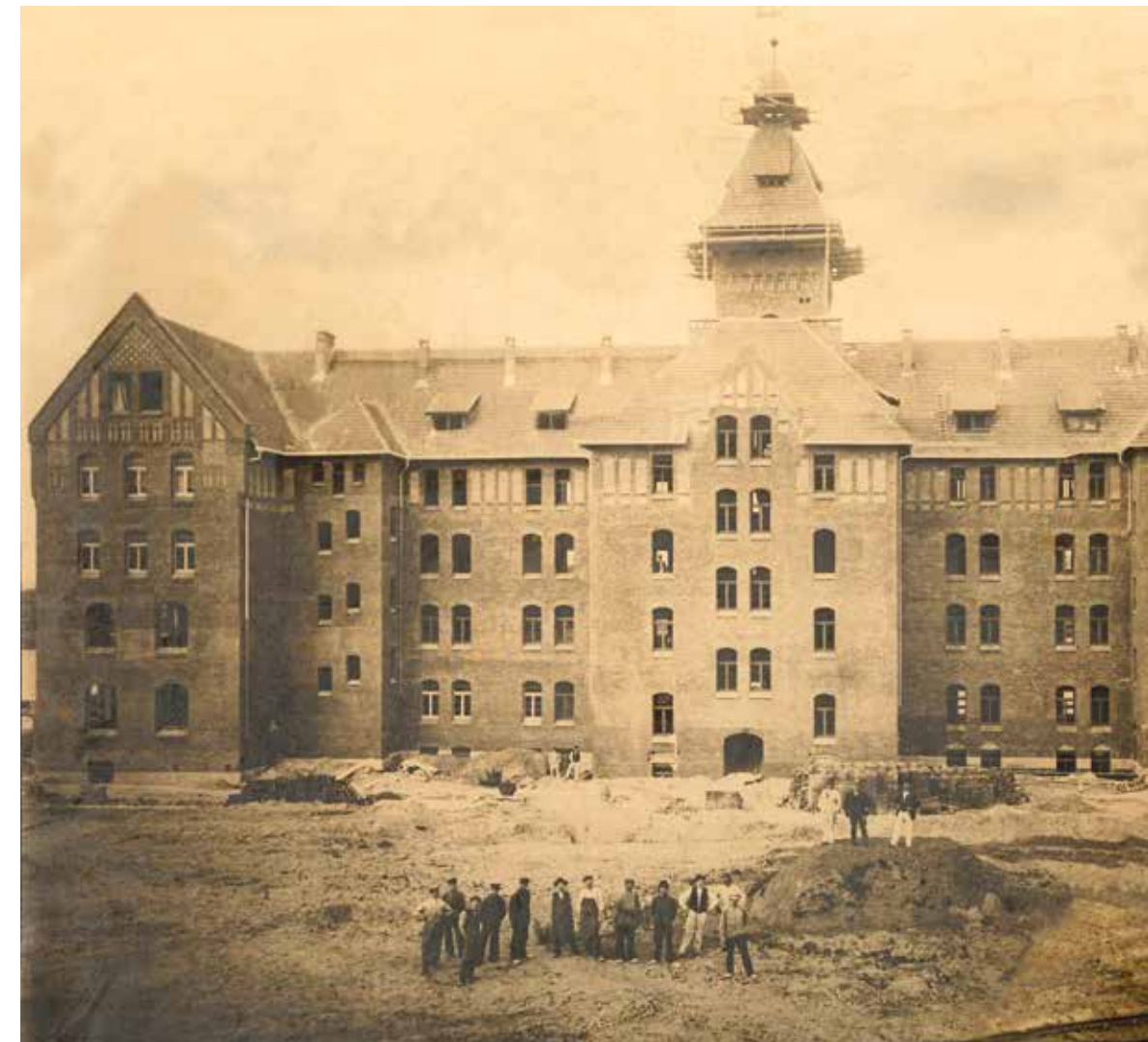
Undervisningsbygningen under opførelse ca. 1905-1906 – set fra gården. Der er stadig stillads omkring tårnet og alle vinduer er ikke monteret endnu. Arbejdere står i vinduerne og på gårdspladsen mellem jordbunker og byggematerialer. Helt forrest ses tipvognssporet (Museum Sønderjylland).
