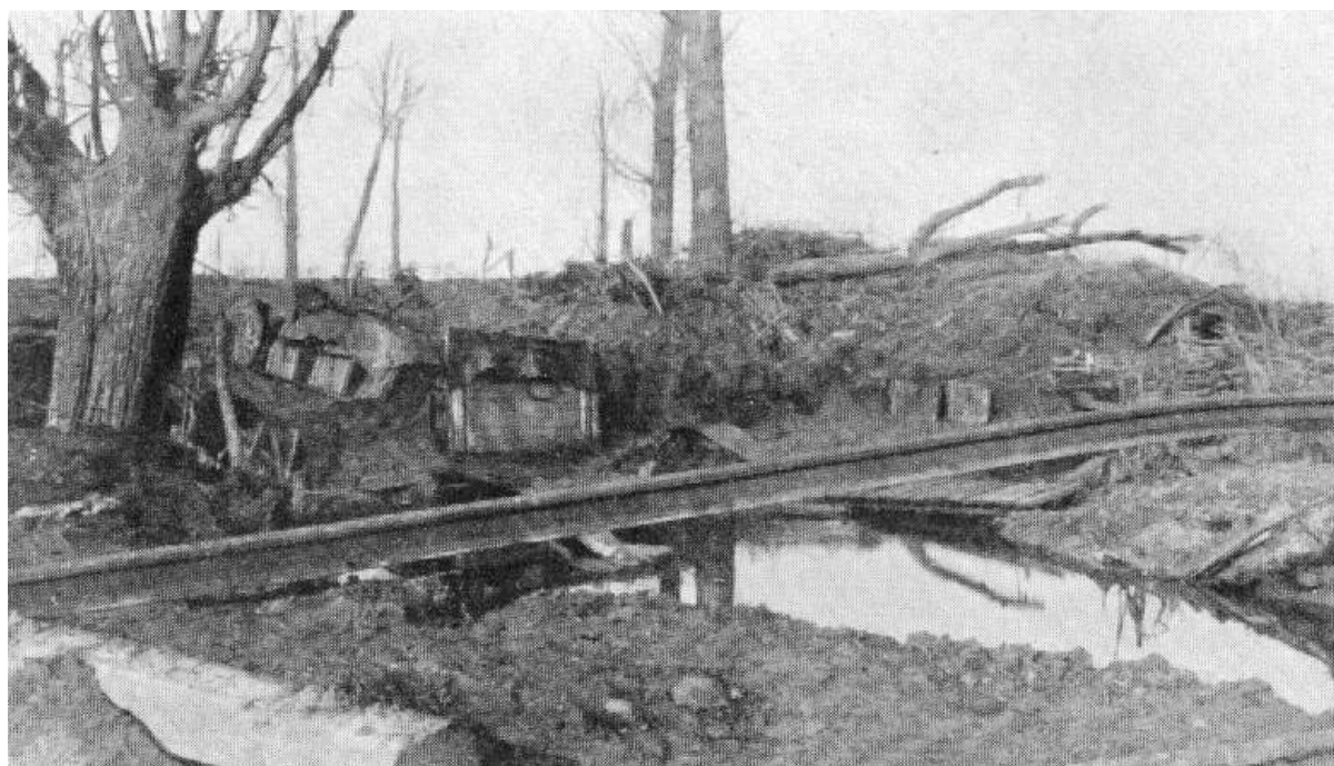
Dækningsrum „Hochburg“ ved Zandvoorde
