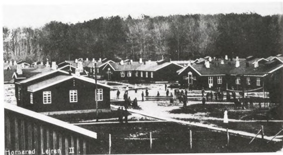
Ved Horserød på Sjælland opførtes i 1917 en barackejr, hvor der behandlede syge krigsfanger. (Museet på Sønderborg Slot)
