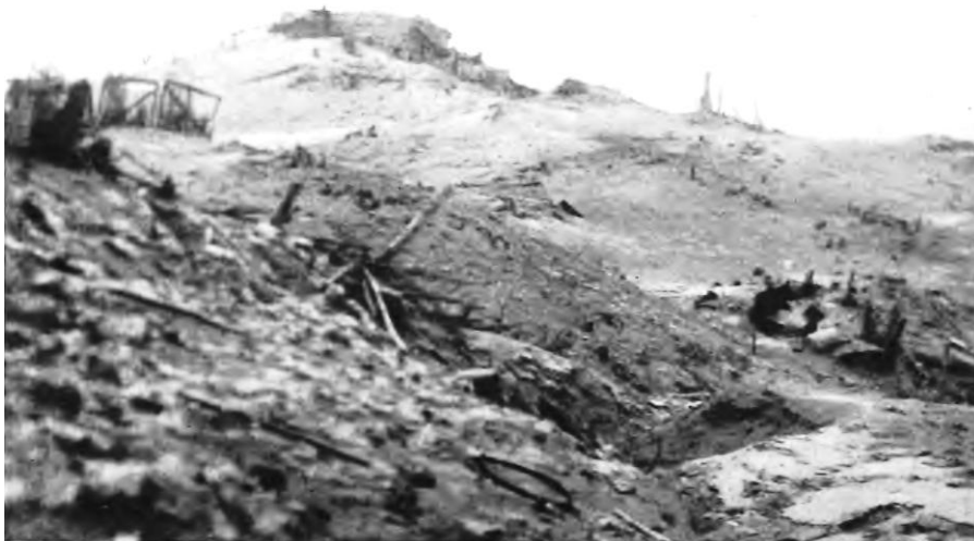
Observationspost B 31 ved Nieuport
