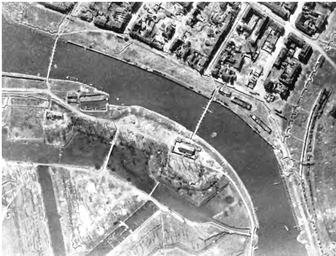
Lufffoto af Nieuport
