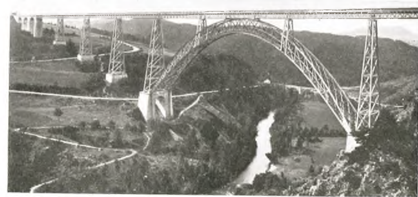
Øverst: Vic-sur-Cère , Panorama fra det smukke Auvergne. I Midten: Indkørslen til den 1800 m lange Tunnel ved Le Lioran i Auvergne. Nederst: Viadukten Garabit ved Saint-Flour , Længde 565 m, Højde 125 m.
